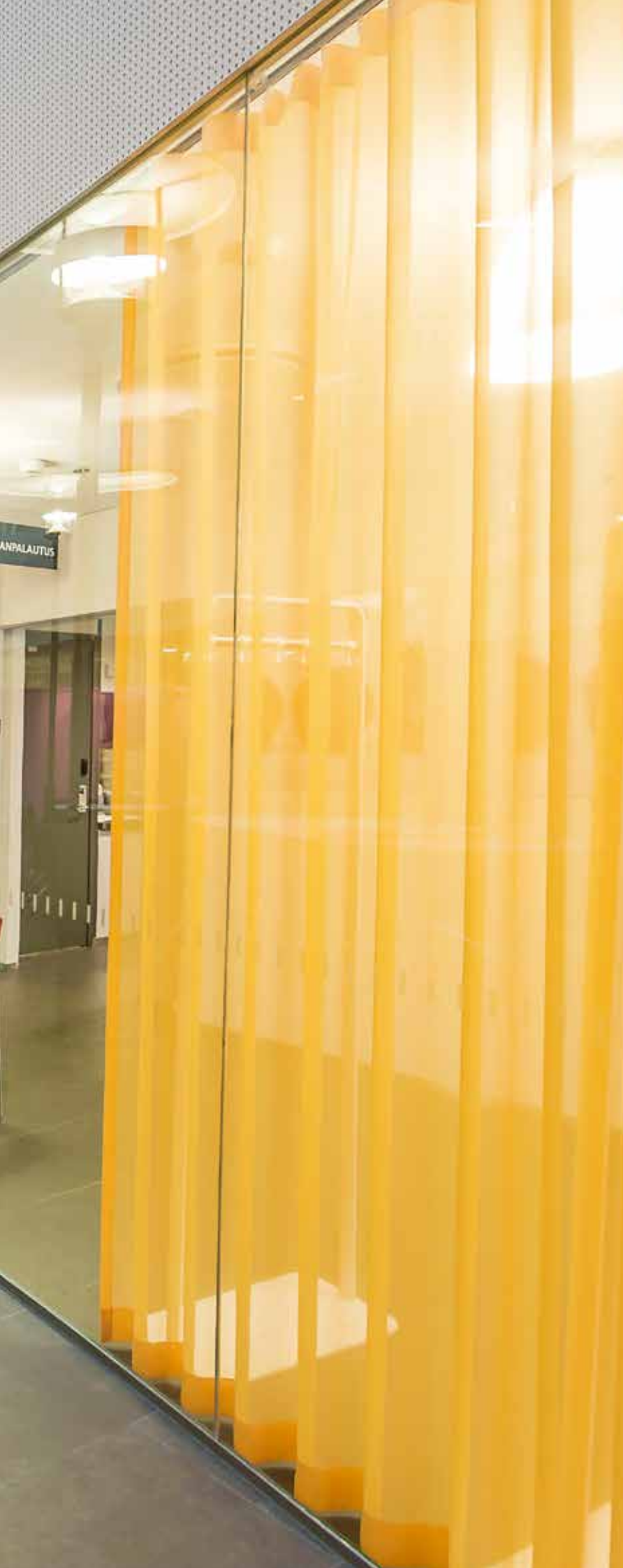
Laseinän silikonisaumattu ulkonurkka
