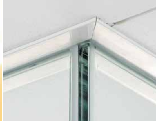
Silikonsammanfogat ytterhörn på en glasvägg
