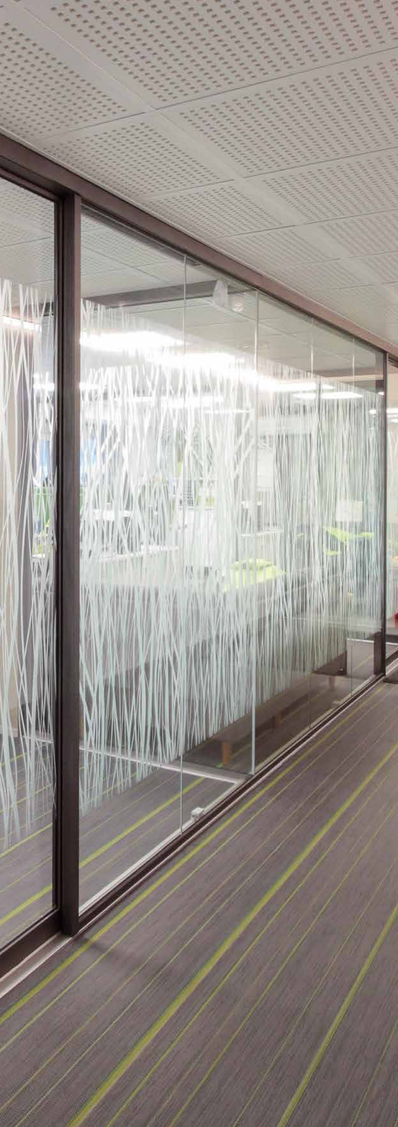
Inlook-verimet kiinnitetään alumiiniprofileihin
