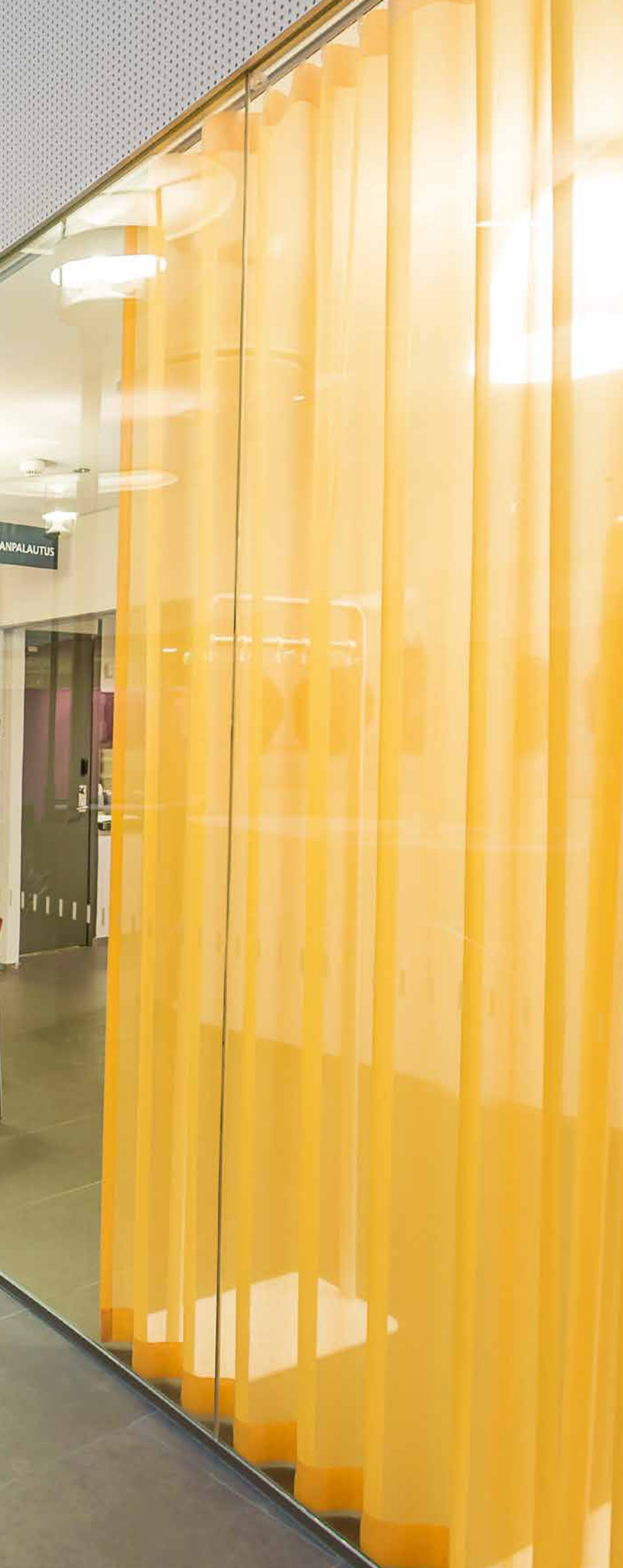
Laseinän silikonisaumattu ulkonurkka
