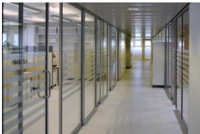
Rakentamispalveluiden toimistotilojen saneeraus toteutettiin vuodenvaihteen jälkeen. Kuvassa pääkäytäväkuva sisääntuloalasta katsottuna.
